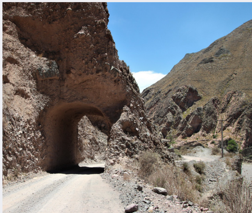
Túnel de Iruya, Ruta Provincial 133, Salta
